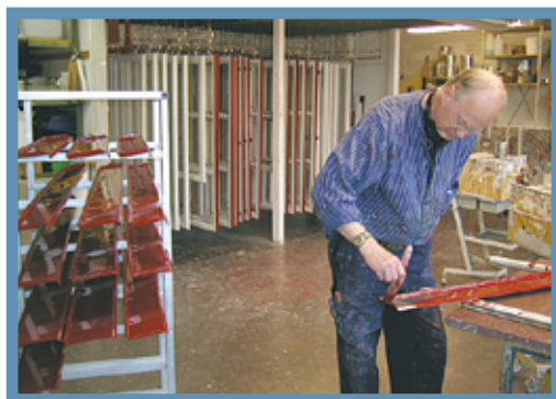
Anstricharbeiten an Fenstern und Fensterblech in der Schule von Bjäresjö, Ystad, Schweden
